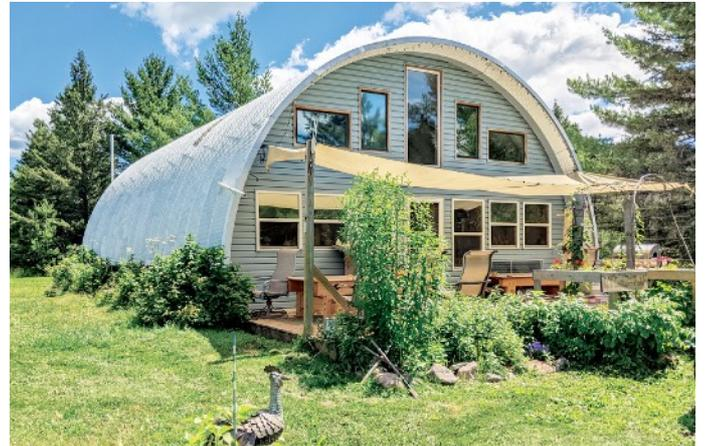
クオンセットハットは、垂鉛メッキ鋼板の波板でできた軽量な構造で、内壁の支持を必要としない。
