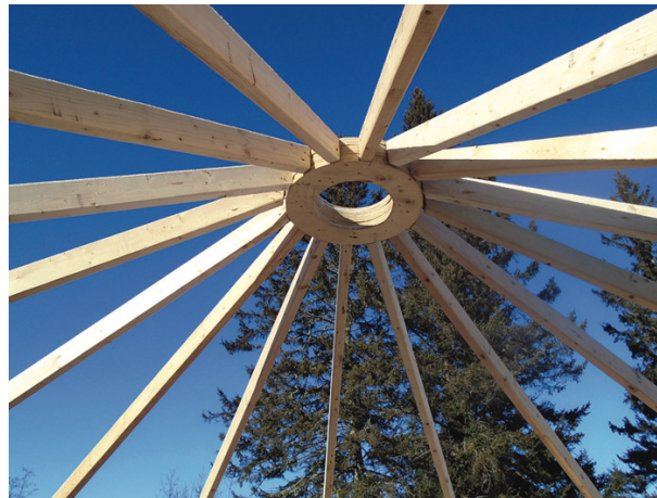
ユルトの屋根の合板フレームは、真ん中に薪ストーブの煙突パイプ用の穴が開いている。
